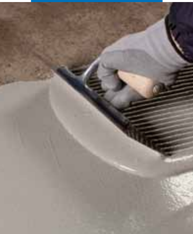
Applicazione della prima mano di Mapelastic Turbo
