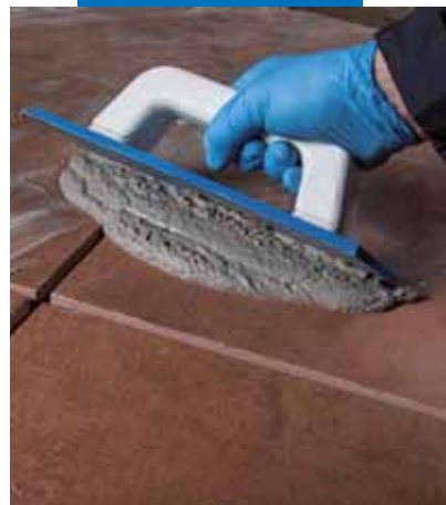
Stuccatura di piastrelle con Ultracolor Plus
