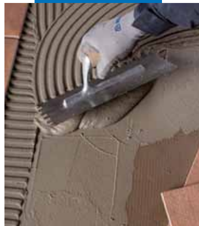
Posa di piastrelle con Elastorapid
